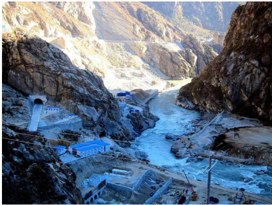
ヤルン・ツァンポー工事現場
