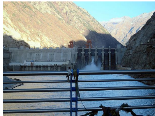
完成したダム、加查付近
