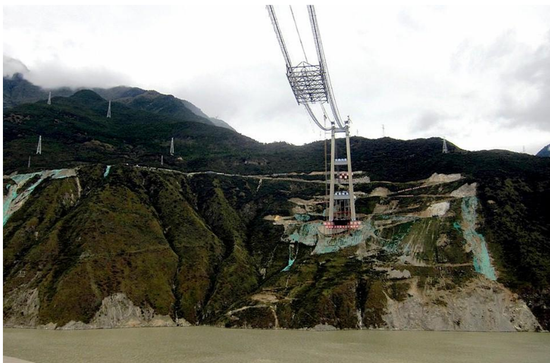
瀘定の北、大渡河に架ける高速道路用の吊橋の大規模工事
